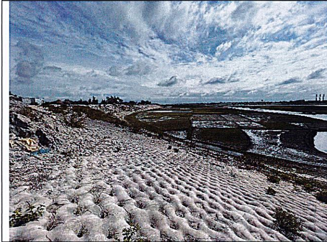
C-14 প্যাকেজে Monitoring of Tranche-1 Pilot Works এর আওতায় প্রকল্পের ISMPC পরাশরক দল কর্তৃক FRERMIP Tranche-1 প্রকল্পের আওতায় Piloting Works হিসেবে বাস্তবায়িত Grout Filled Jute Mattress দ্বারা বাঁধের ঢাল প্রতিরক্ষা কাজের কার্যকারিতা পর্যবেক্ষণাধীন রয়েছে। কমিটি উক্ত কাজ পরিদর্শন করেন।
