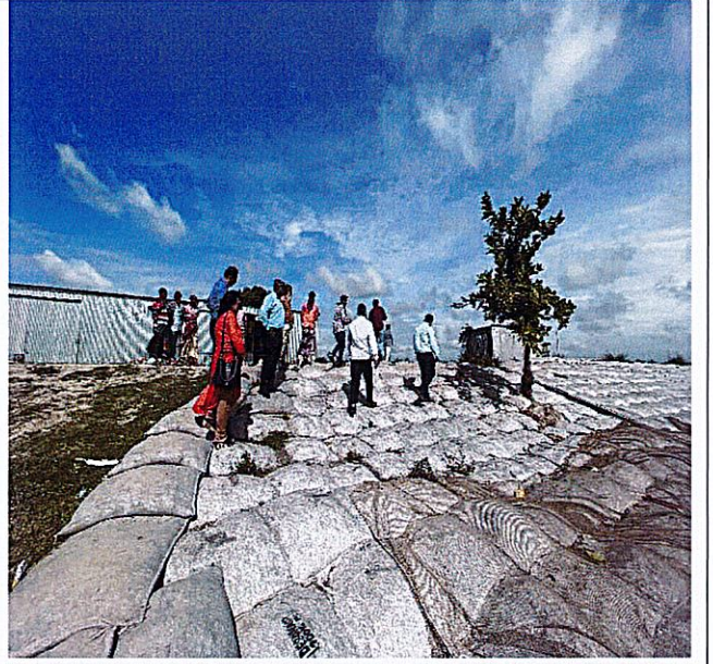
W-11 প্যাকেজের আওতায় সিরাজগঞ্জ জেলার শাহজাদপুর উপজেলায় বিদ্যমান বন্যা নিয়ন্ত্রণ বাঁধের পুনরাকৃতিকরণ, রক্ষণাবেক্ষণ ও ঢাল প্রতিরক্ষা পরিদর্শন
